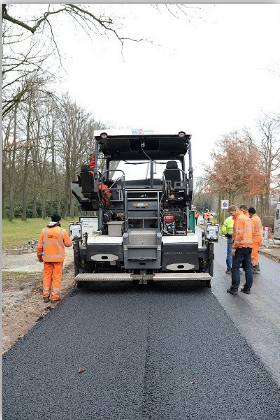
De spreidmachine aan de gang
