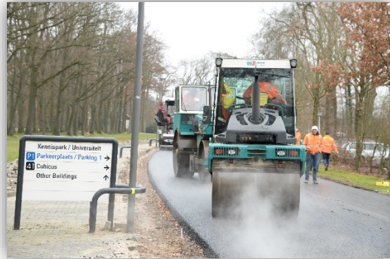
Verdichting van de deklaag na sensor installatie
