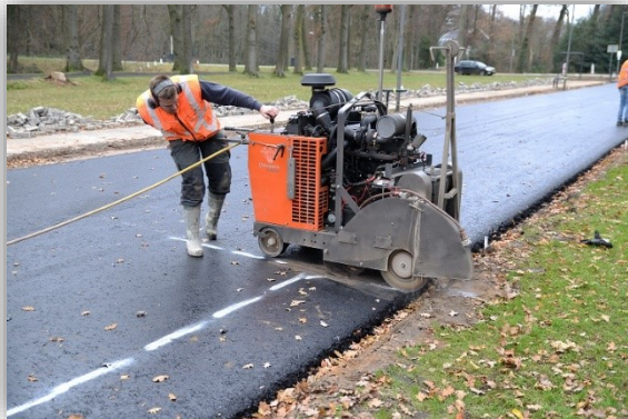
Vorbereiding voor de FBG sensoren
