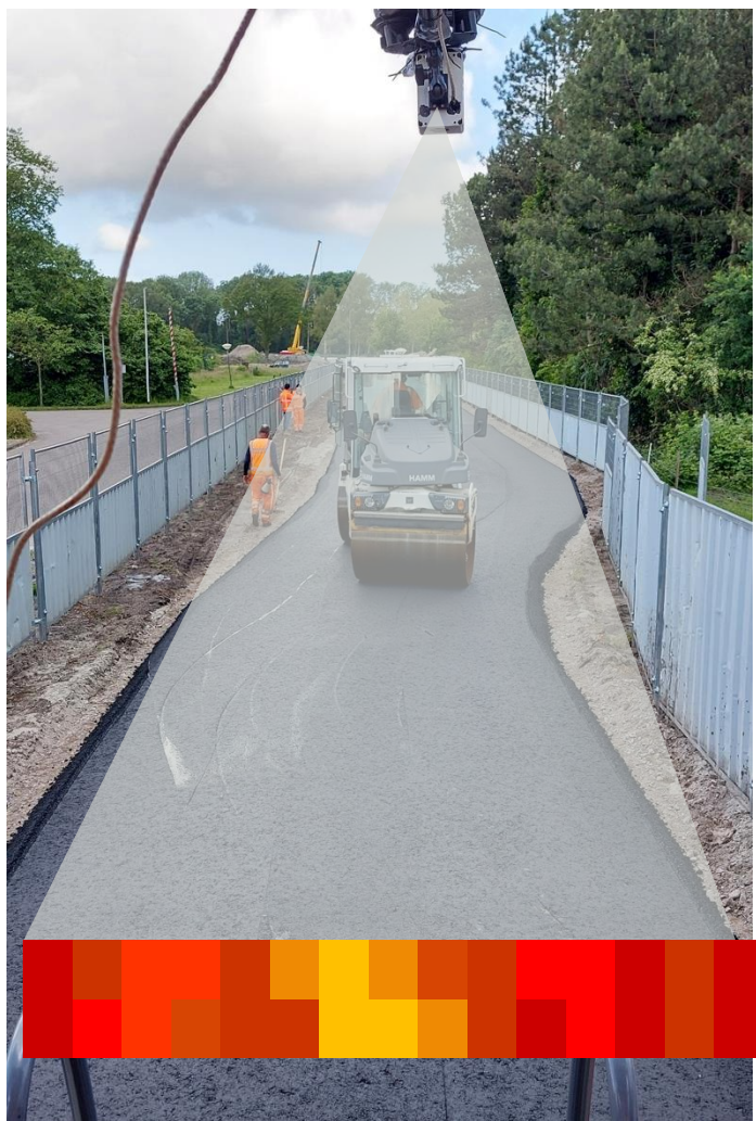
Warmtebeeld + GPS Asfaltspreidmachine
