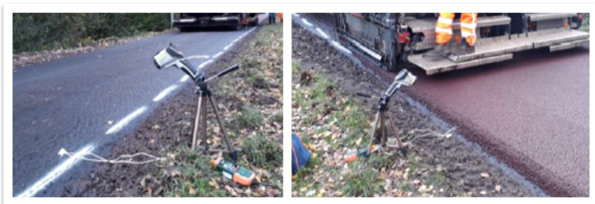
Opstelling meetapparatuur (ASPSARi Cooling Curve Calibration Unit) vóór (links) en na (rechts) aanbrengen van asfalt
